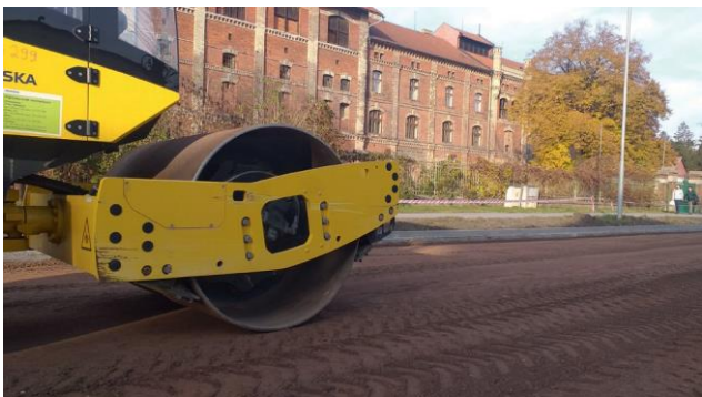
Hutnění rozprostřené vrstvy vibračním válcem
