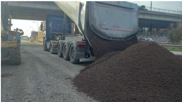
Materiál přivezený z betonárny na stavbu
