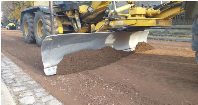
Rozprostření grejdrem do požadované výšky a spádu
